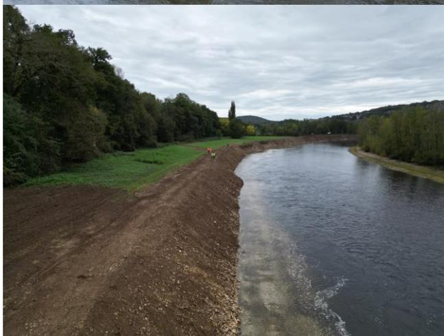
**Desenrochement et réinjection de 6000 m<sup>3</sup>** de roches concassés dans le lit mineur pour lutter contre le phénomène d'enfoncement du lit (incision – chenalisation) à l'origine de la déconnexion des annexes fluviales (couasnes).
